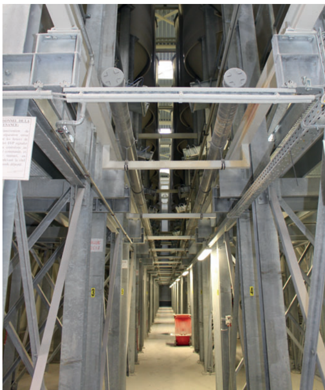
34 бункера для заполнителей расположены в два ряда
