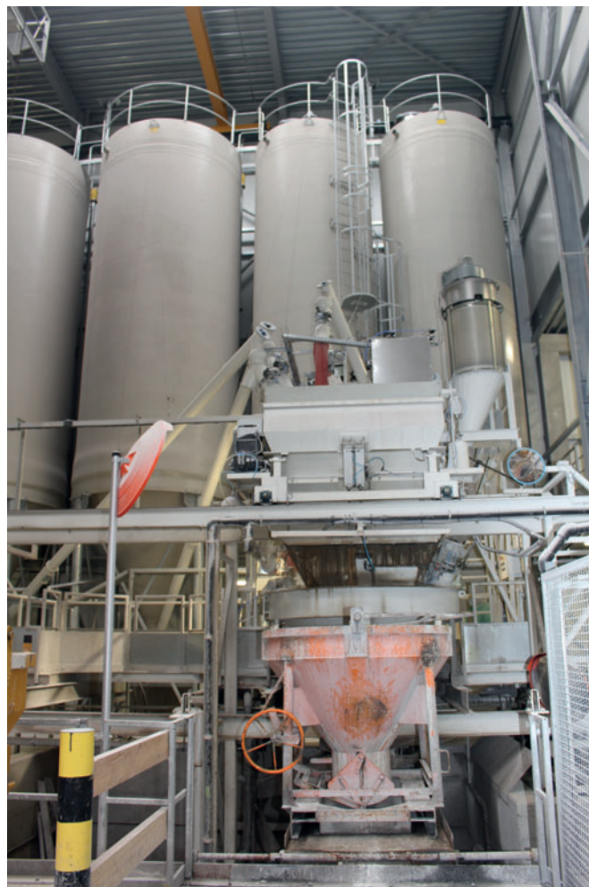
Смеситель опорожняется непосредственно в бадью, которая перемещается на поперечной платформе, смонтированной на передвижной тележке
