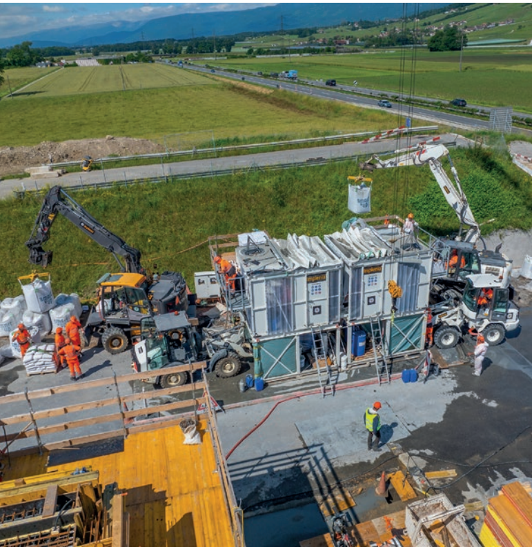
Die Beschickung der Anlage erfolgt durch Big-Bags.
